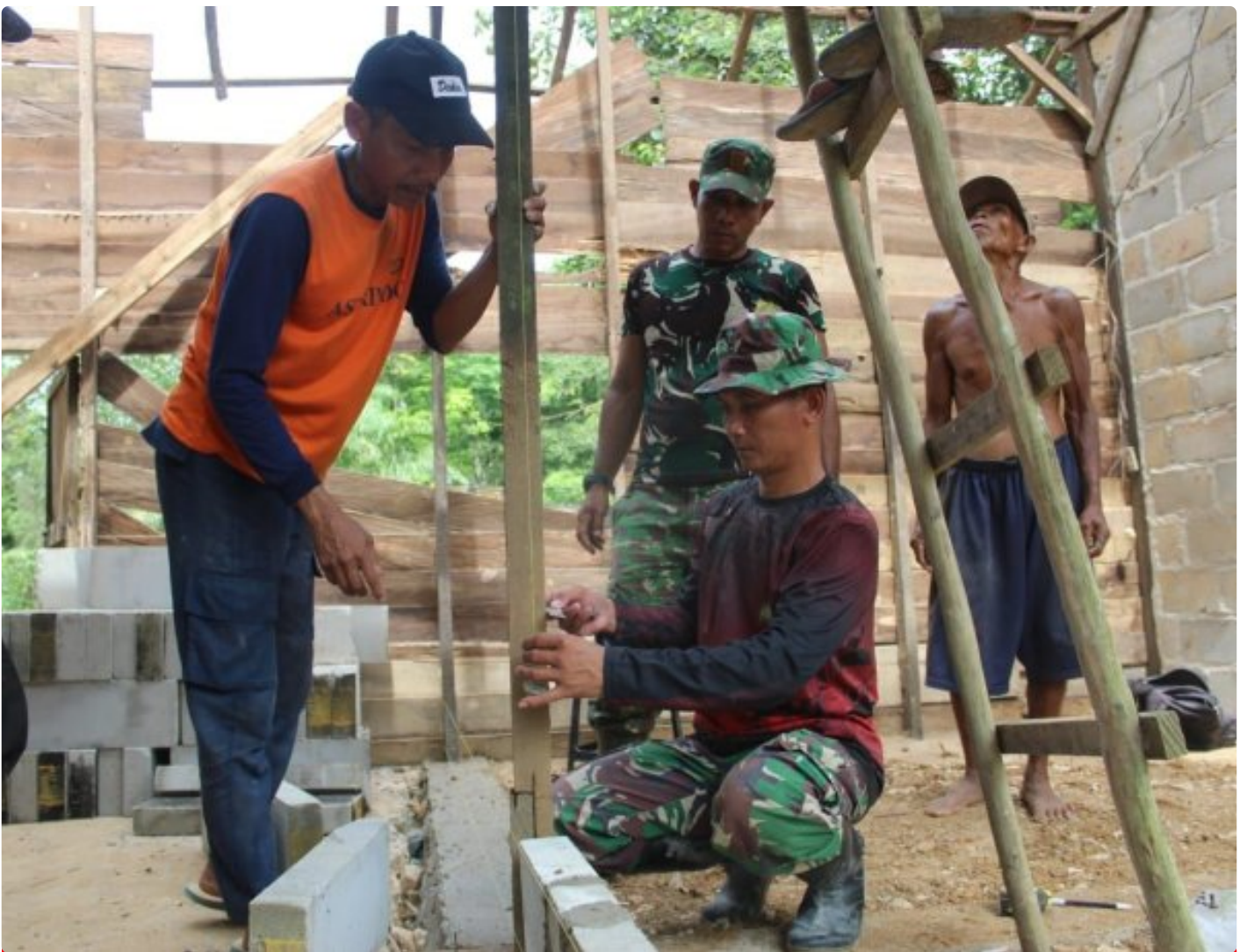
Sasaran Bedah Rumah, Sudah Tahap Pemasangan Dinding
