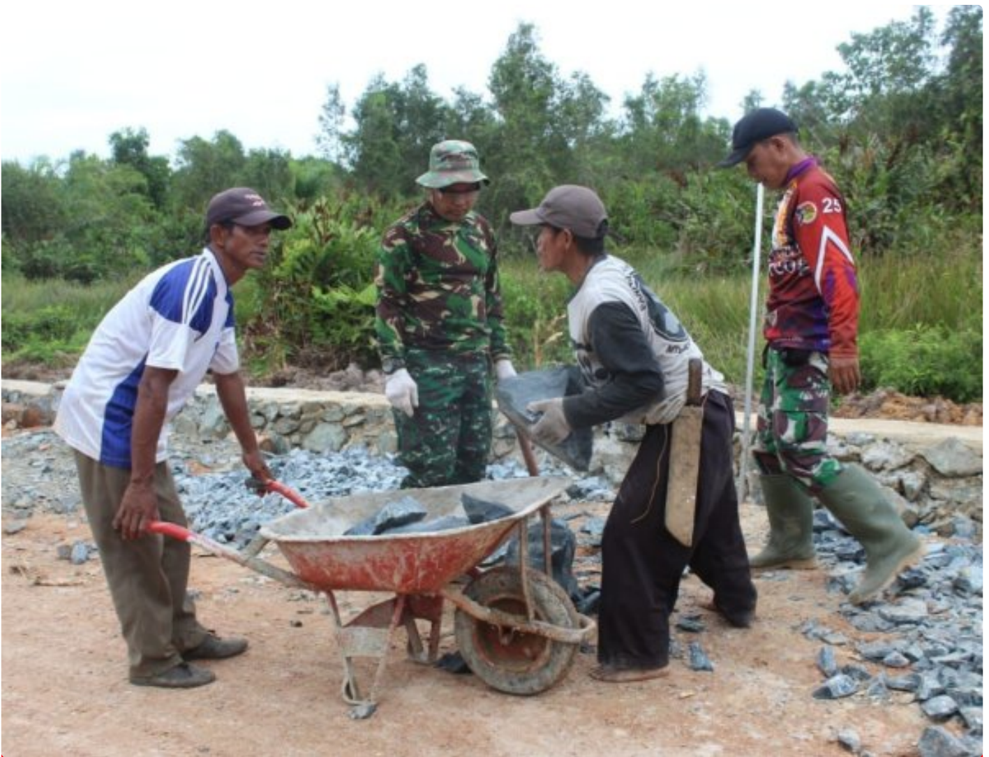
Personel Satgas TMMDKe - 117, Kerjakan Siring Jalan
