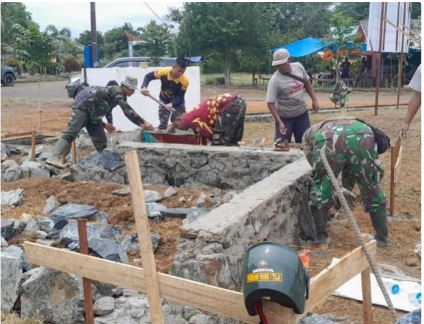
Pembangunan Pos Kampling, Di Targetkan 10 Hari Rampung
