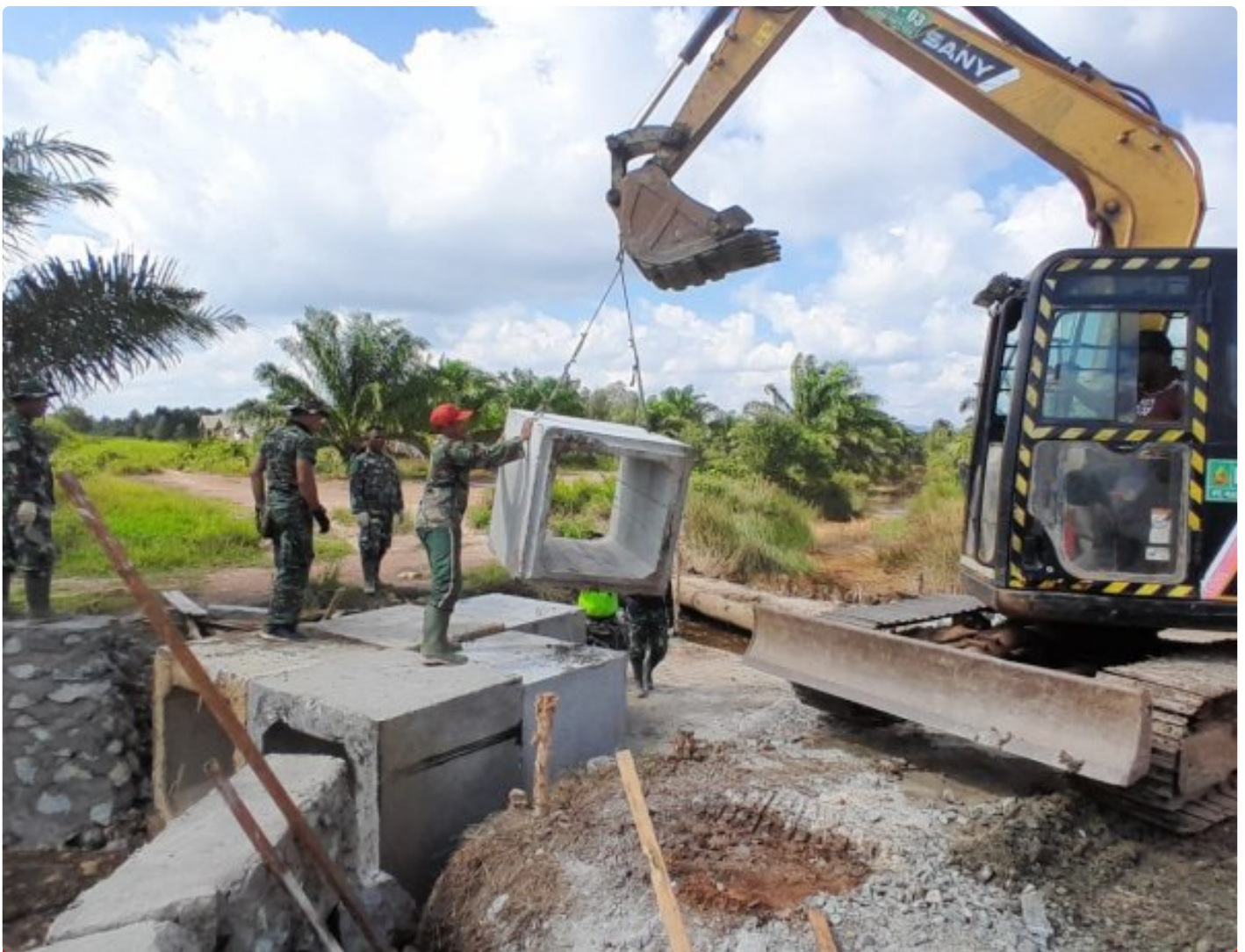
Box Culvert Jembatan Penghubung Desa Telaga Langsung Mulai Dipasang
